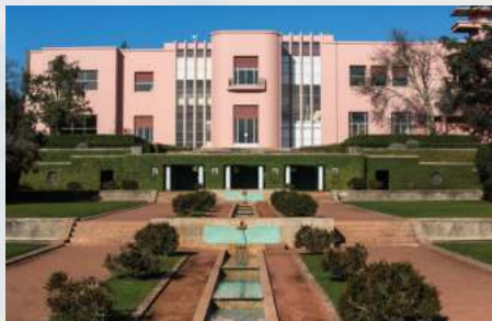
Fundação de Serralves – Porto
