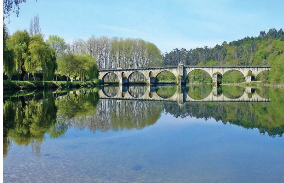
Ponte sobre o Lima – Ponte da Barca
